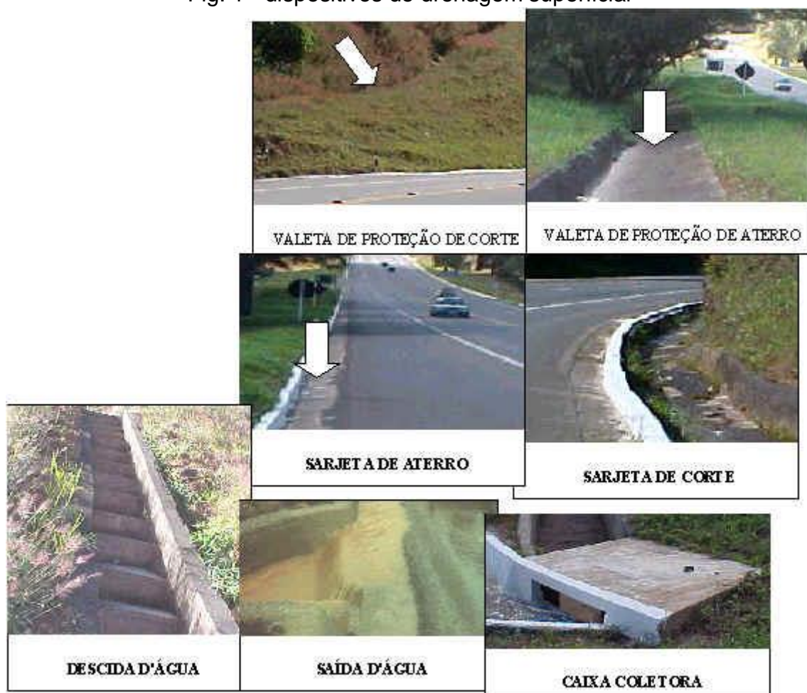
Fig. 1 - dispositivos de drenagem superficial
