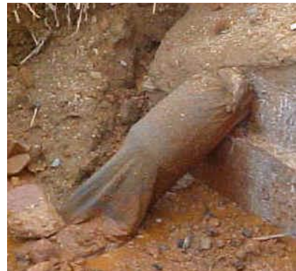
saída de dreno longitudinal profundo, com geotextil.
